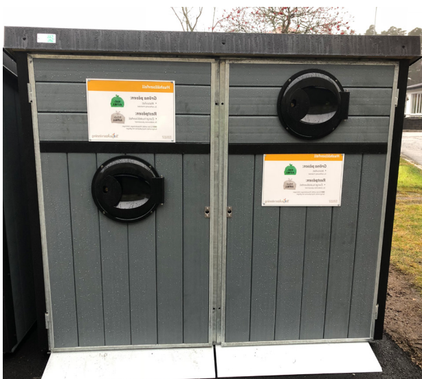
Kärskåp med nedsänkt inkasthåll för att öka tillgängligheten. FOTO: TELGE AB.
