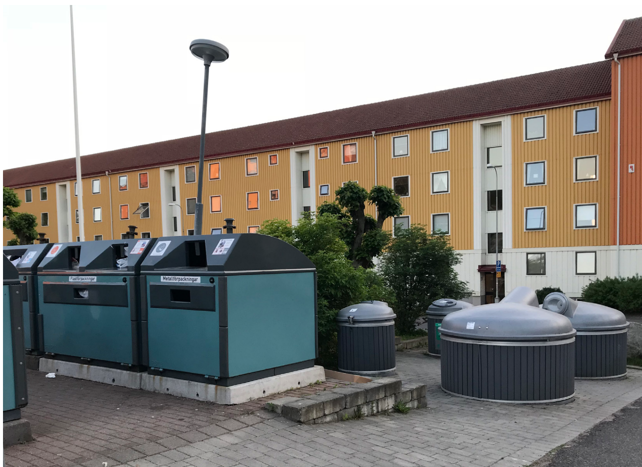
Bottentömmande behållare ovan mark (till vänster i bild) och underjordsbehållare med insatssäck (till höger i bild). FOTO: REBECKA JAKOBSSON, RAMBOLL.
